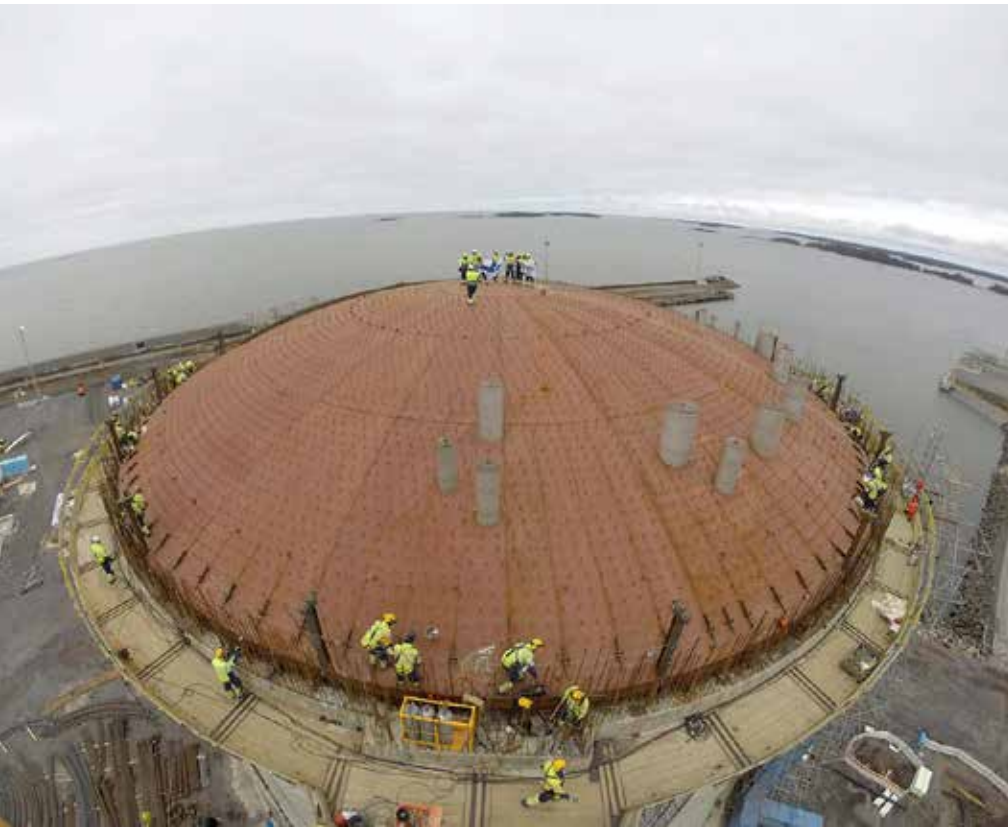
Suomen ensimmäinen LNG-tuontiterminaali on rakenteilla Poriin Tahkoluodon kemikaalisatamaan. Terminaalin on määrä valmistua elokuussa 2016.
