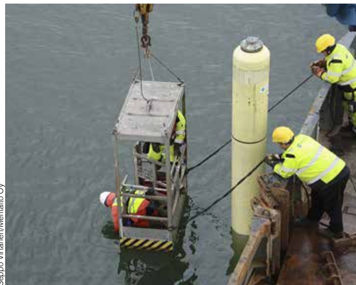
Älypoijua asennetaan Porvoon edustalla.
