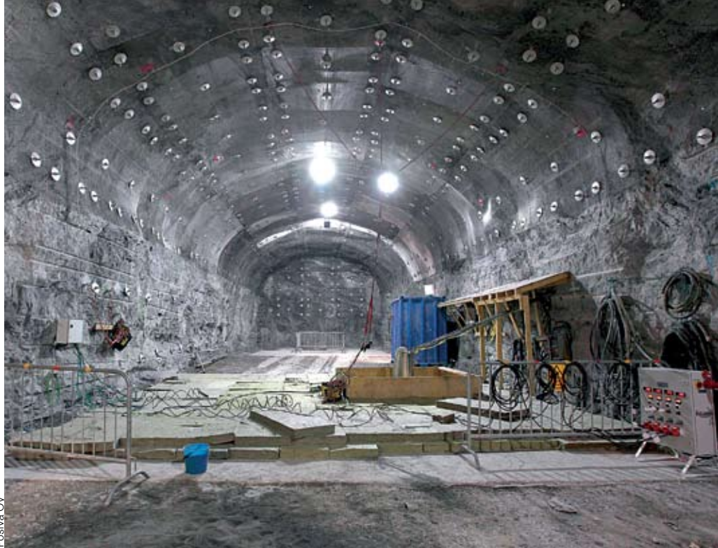
Posivan on tarkoitus aloittaa ydinjätteen loppusijoittaminen ensimmäisenä maailmassa. Jäte haudataan Olkiluodon kallioperään porattuun luolastoon 420 metrin syvyyteen.
