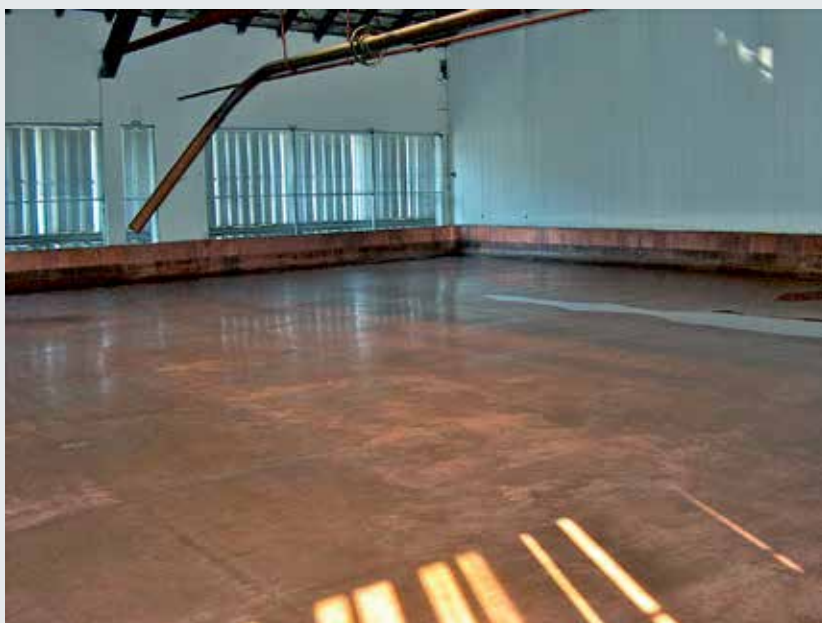
Lambic-olutta tehdään muun muassa Timmermansin panimossa. Vierre lasketaan jäähtymään ja käymään matalaan kuparialtaaseen.
