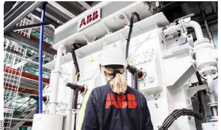
Kelluvan jättituulivoimalan muuntajat valmistetaan ABB:n Vaasan-tehtaassa.
