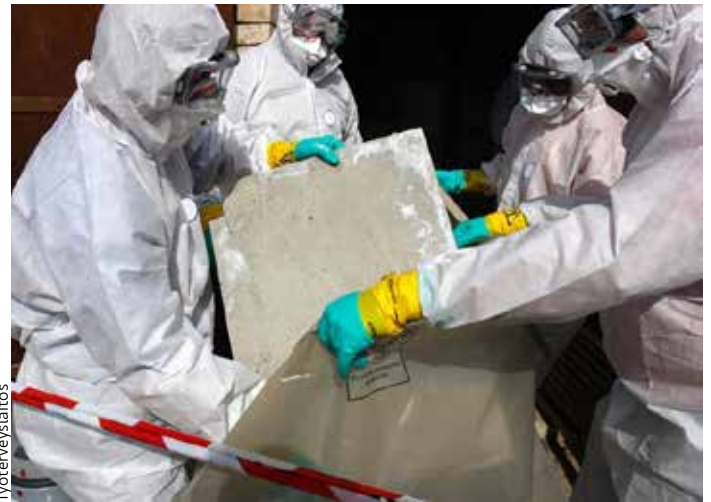
Asbestin käyttö rakentamisessa kiellettiin kokonaan vuonna 1994. Aineelle altistutaan kuitenkin yhä, nyt vanhojen rakennusten korjaus- ja purkutöissä.
