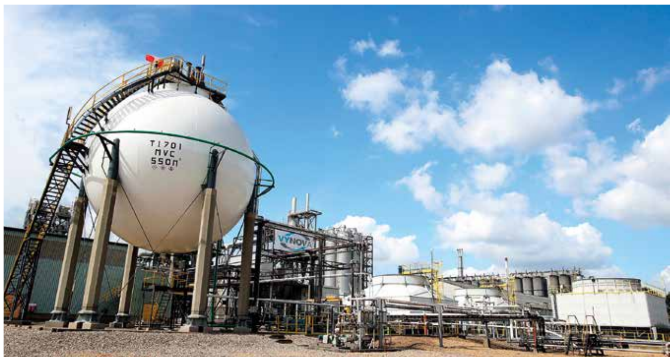
Muoviyritys Vynovan Beekin tuotantolaitos Alankomaissa hyödyntää pvc-muovin valmistuksessa suspensiopolymerointia. Lähtömateriaali vinyylidikloridimonomeeri tulee yhtiön Tessenderlon tehtaasta Belgiasta.
