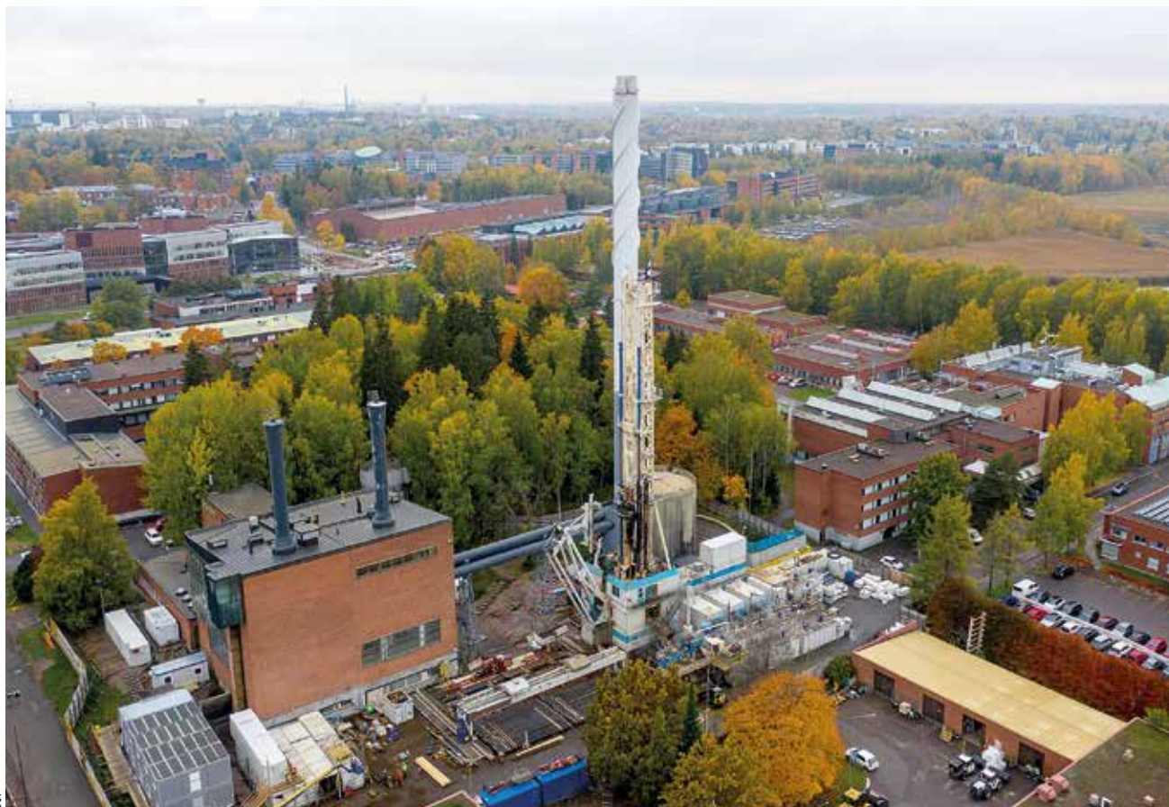
Otaniemessä käynnistyvä geolämpövoimala ammentaa maankuoren valtavista energiavarastoista.
